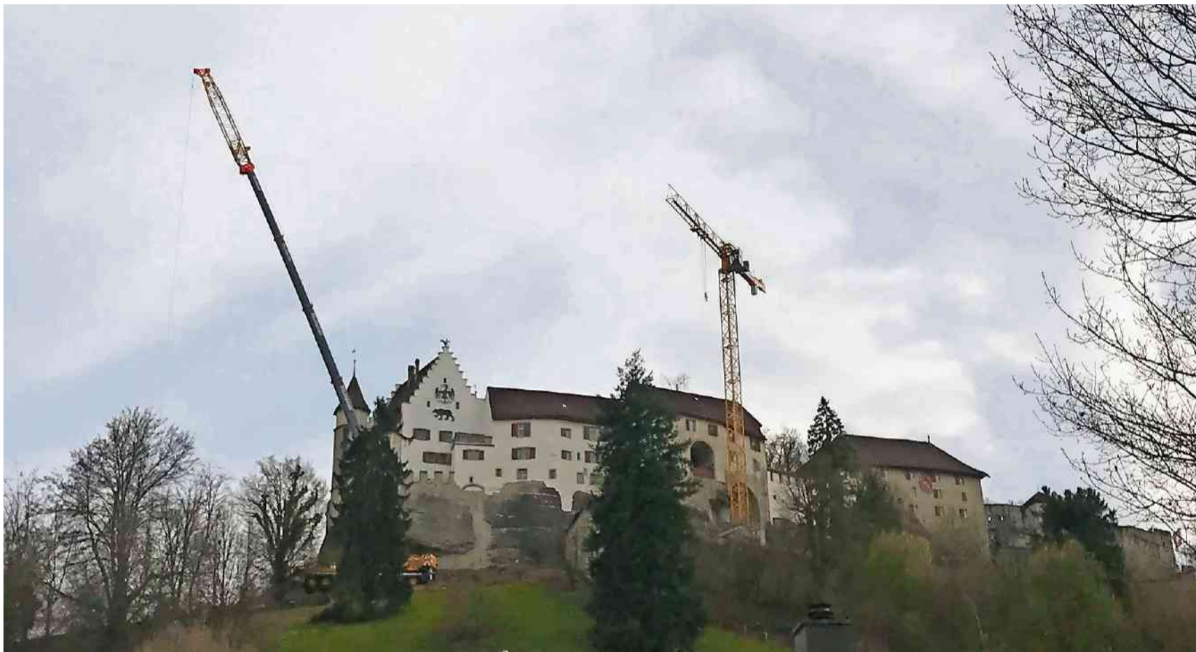
Am frühen Abend hatte der Kran für die Sanierung (rechts) seine Höhe erreicht, für den 60 Meter langen Arm fehlten noch einige Elemente.
