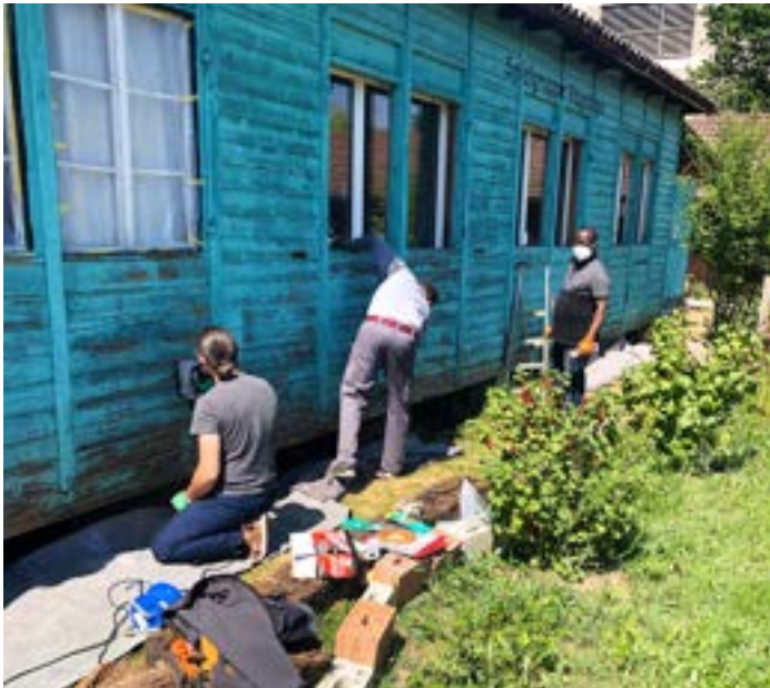
Anspruchsvoll war das Schleifen des alten Gebäudes ...
